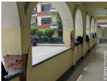
Couloir extérieur d'accès aux classes.
