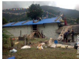
Travaux sur le toit du dispensaire de la vallée de Dhorpatan.
