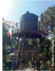
Un des réservoirs d'eau tout beaux à Gopalpur.
