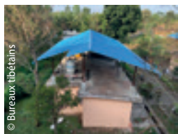
Et les remerciements de STS Bylakuppe pour le projet voté en juin dernier. Les travaux sont bien commencés !
