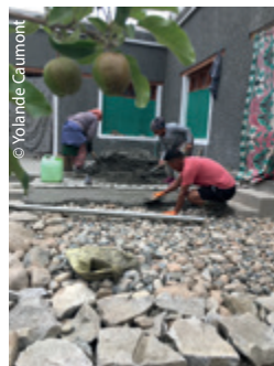
En pleins travaux, juillet 2019.
